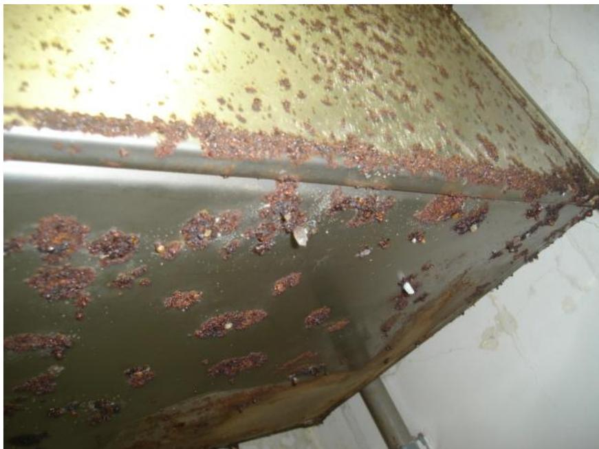
Foto2: Aspecto externo mostra, de dentro do duto para fora, corrosão por pite em aço inoxidável AISI304 em Copacabana no Rio de Janeiro.
