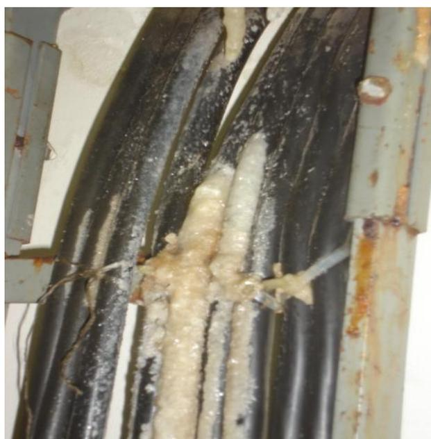
Foto3: Aspecto superficial com a formação de estalactite no leito de cabos mesmo na posição vertical, superfície aquecida, numa subestação elétrica de bombeamento em Copacabana no Rio de Janeiro.
