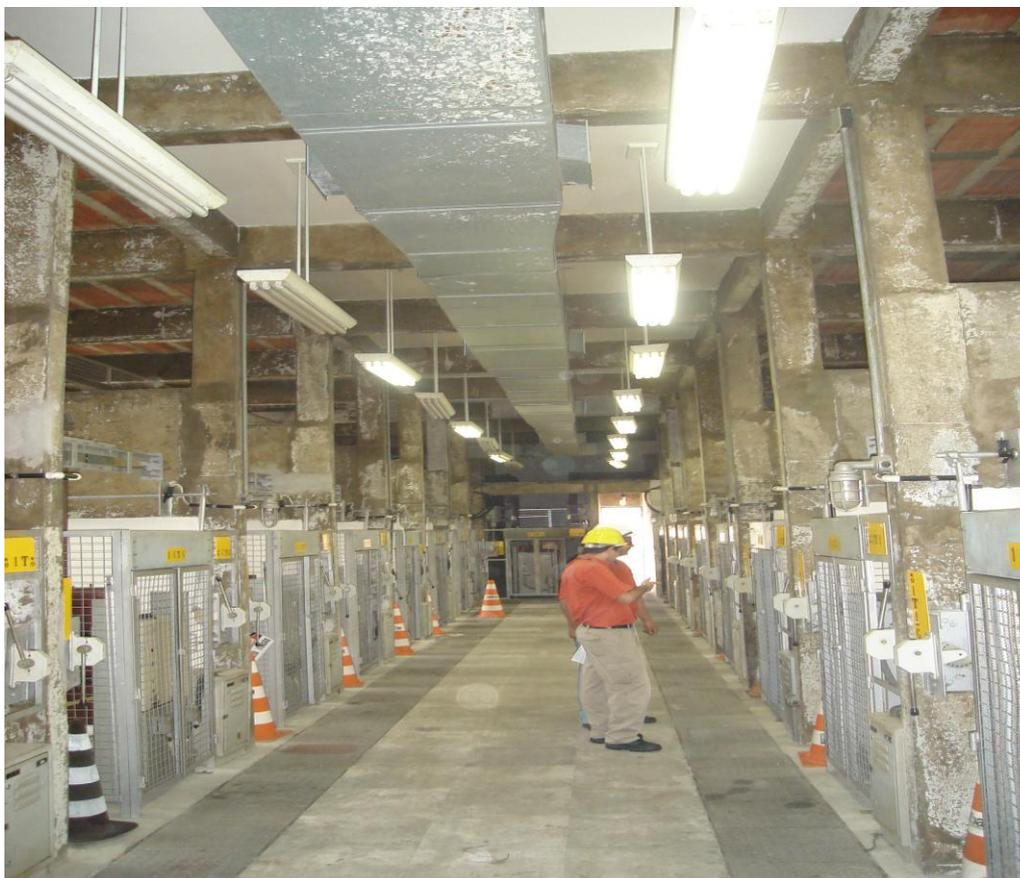
Foto1: Aspecto interno das celas com linha de dutos, no eixo longitudinal, de insuflação de ar resfriado e dessalinizado por centrifugação líquida, mantendo a subestação em pressão positiva.
