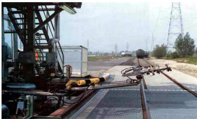
Figura 4: Braço férreo de carregamento, tecnologia racional com reduzidas taxas de emissão de COV.
