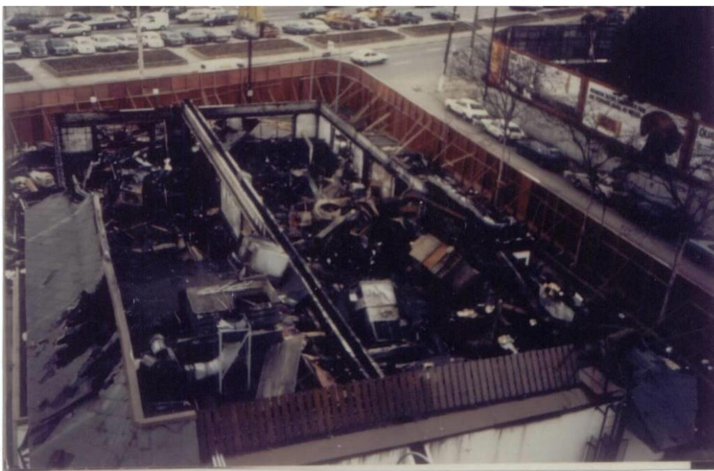
Foto 3: Registro pelo Corpo de Bombeiros de S.Paulo de incêndio iniciado na fritadeira e que ao alcançar filtro eletrostático deu-se o efeito “bucha” com destruição integral da construção.
