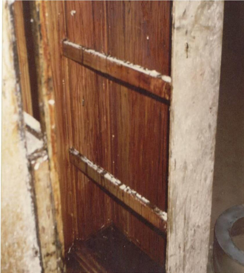
Foto 5 : Detalhe do arcabouço da carenagem impregnado localizado na casa de máquinas e que deve ser limpo
