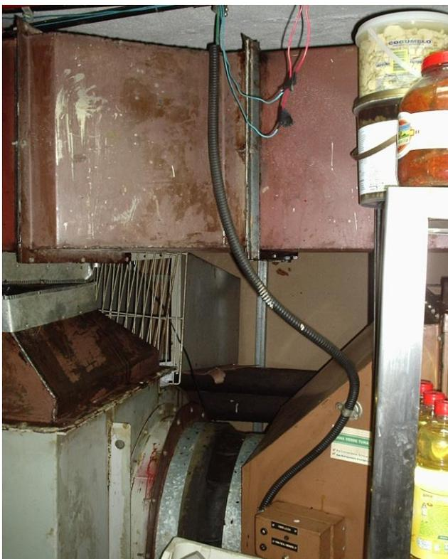
Foto 8 e 9: Flagrantes de falta de estanqueidade construtiva que dirá resistência á fogo, bem como flange flexível untado de gordura após filtro eletrostático, caracterizando a baixa eficiência.
