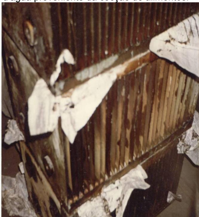
Foto 2: Células removidas para serem conduzidas desde casa de máquinas até ao local com Água para limpeza por imersão sendo inclusive possível inferir da necessidade de joga sobressalente para operação durante a demorada remoção dos poluentes aderidos e impregnados(peso unitário mínimo de 8 Kg para opção em alumínio)
