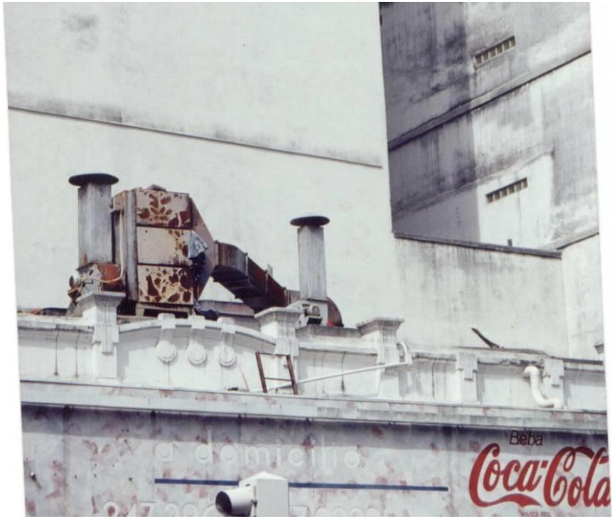
Foto 6: Filtro eletrostático com efeito “bucha” em Ipanema –RJ.
