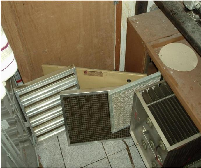
Foto 7: Filtro colméia totalmente impróprio trabalhando em série com as células eletrostáticas com objetivo de reduzir a carga de poluentes visto que o filtro eletrostático não suporta elevadas concentrações de poluentes, usa-se ainda o pós-filtro cuja finalidade é questionável .
