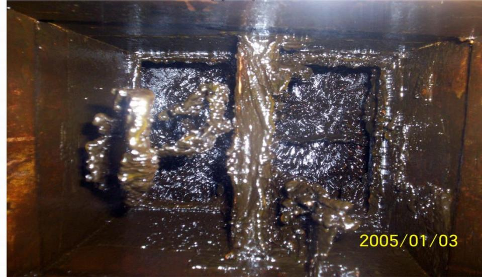
No recomendado uso de registros, ejes direccionales y dampers anclaje de grasas y mantenimiento difíciles
