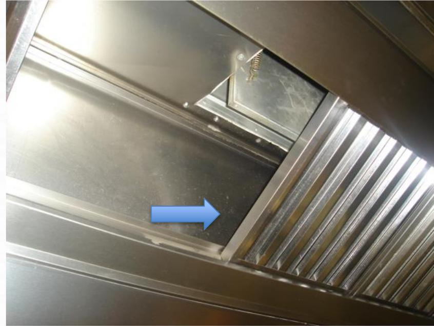
Aspersores en cámara de saturación líquida a eficiente condensación de vapor de agua, aceites, grasas de partículas medias ( $> 5 \mu$ ) con seguridad contra incendios  $\eta \leq 70\%$
